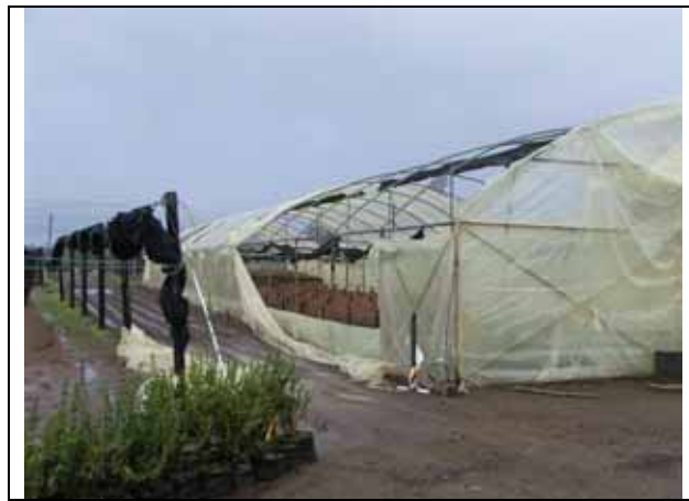
Daño por Viento en Invernadero
